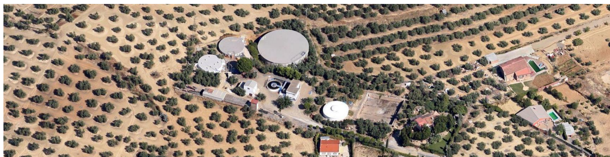
Depósitos Camino de las Aguas | F: E.I.E.L. Visor
